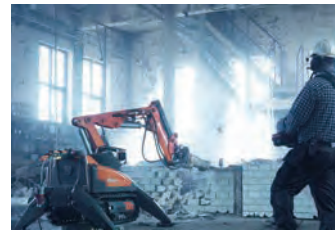
El primer robot de demolición por control remoto
