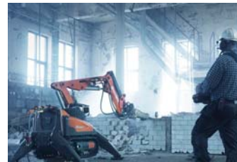
El primer robot de demolición por control remoto
