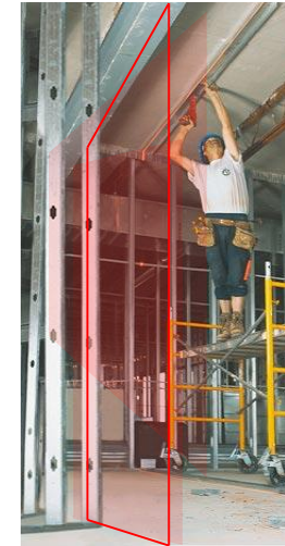
Área de referencia en instalación de una pared de drywall.
